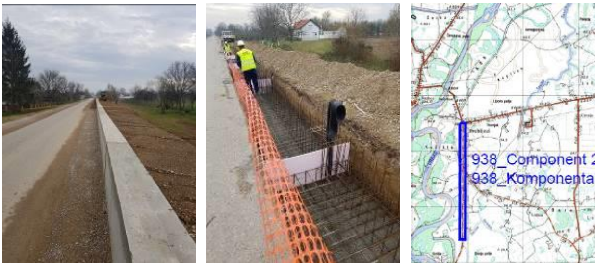
Slika 5.3.1. Podizanje nivoa zaštite na postojećem desnom vrbaskom nasipu u Prijebljezima - izgradnjaparapetnog zida – investiciona mjera u realizaciji (izvor: TG28 – Hitne mjere na umanjeњу poplavnog rizika u Republici Srpskoj)
