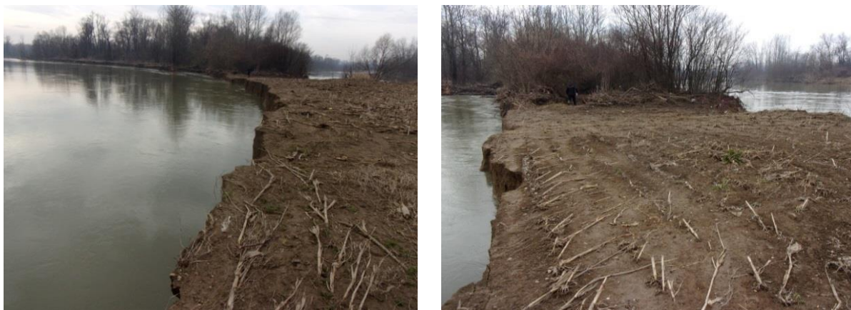
Slika 6.2.2.3. Presjecanje meandra sa slike broj 2.4 – lokalitet Trnjačani (februar, 2019. godine)
